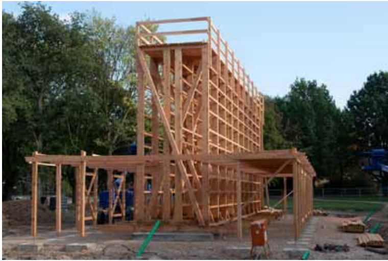
Das Gerüst des Gradierwerks steht bereits
